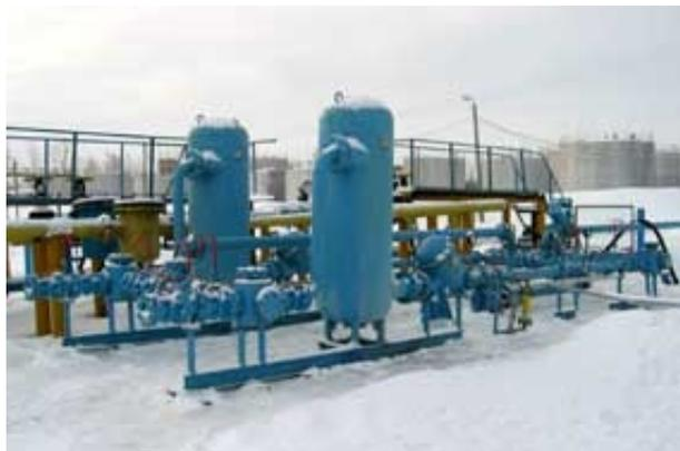
**Назначение:** комплексы измерительные УНМ-100 и УНМ-150, устанавливаемые в линию трубопровода, предназначены для измерения объёма и массы перекачиваемого нефтепродукта при внутрихозяйственных и коммерческих учётных операциях.
