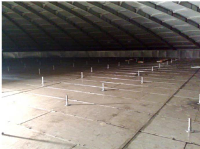
**Описание:** непотопляемый двудечный полноконтактный понтон нового поколения представляет собой конструкцию, состоящую из герметичных алюминиевых блоков размером 3000х900х40 мм, заполненных жестким самозатухающим пенополиуретаном.
